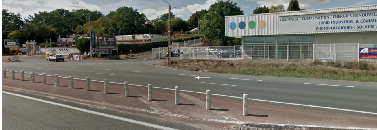
1. La zone d'activité depuis la D910, légèrement encaissée
